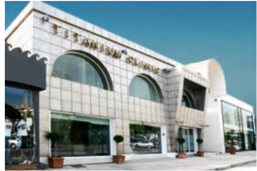
Die Fassade der Titanium Clinic in Marbella ist mit 100 Zwei-Millimeter-Titanplatten verkleidet.
